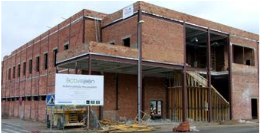
Obras del edificio Activa, que se inauguró en la edición 2007 de la feria.
