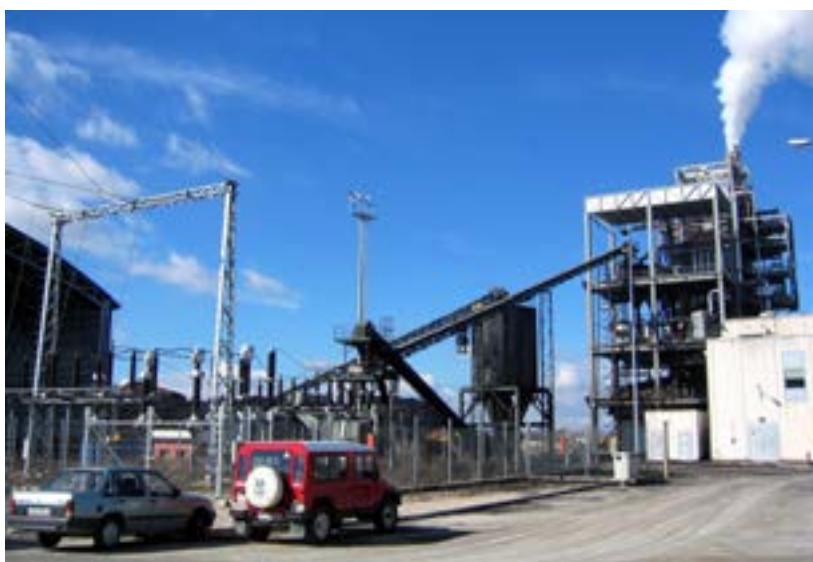
Central eléctrica utilizando biomasa en la provincia de Jaén.
